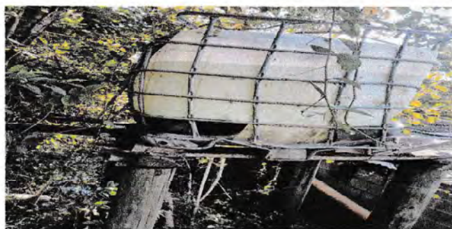
Foto 1: Sistema de mala calidad y en muy malas condiciones
